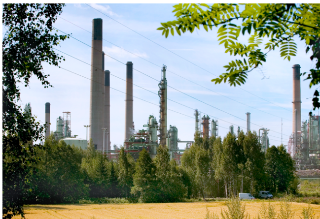
Neste Porvoo refinery
